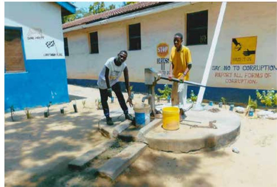
Bisherige Wasserversorgung: das angekaufte Trinkwasser wird in einem unterirdischen Tank gelagert und per Pumpe in Kanister und Eimer gepumpt.
